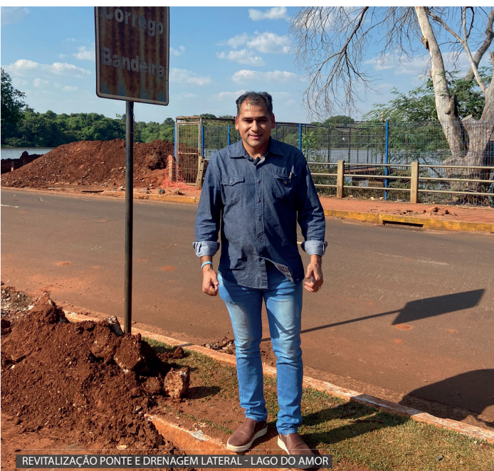
REVITALIZAÇÃO PONTE E DRENAGEM LATERAL - LAGO DO AMOR
