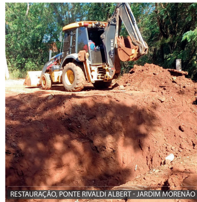
RESTAURAÇÃO, PONTE RIVALDI ALBERT - JARDIM MORENÃO
