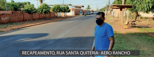
RECAPEAMENTO, RUA SANTA QUITÉRIA- AERO RANCHO
