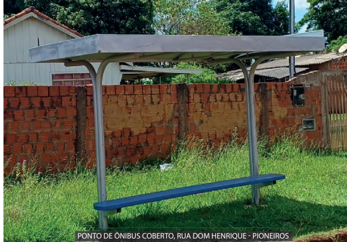
PONTO DE ÔNIBUS COBERTO, RUA DOM HENRIQUE - PIONEIROS
