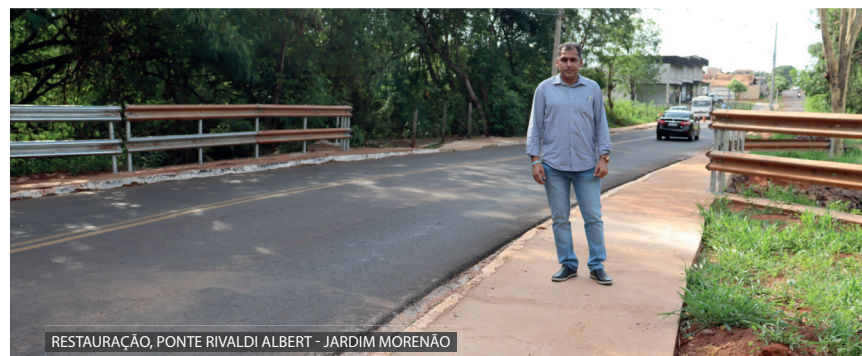
RESTAURAÇÃO, PONTE RIVALDI ALBERT - JARDIM MORENÃO
